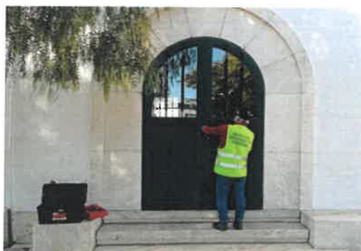
Reparação de portão de Escola
